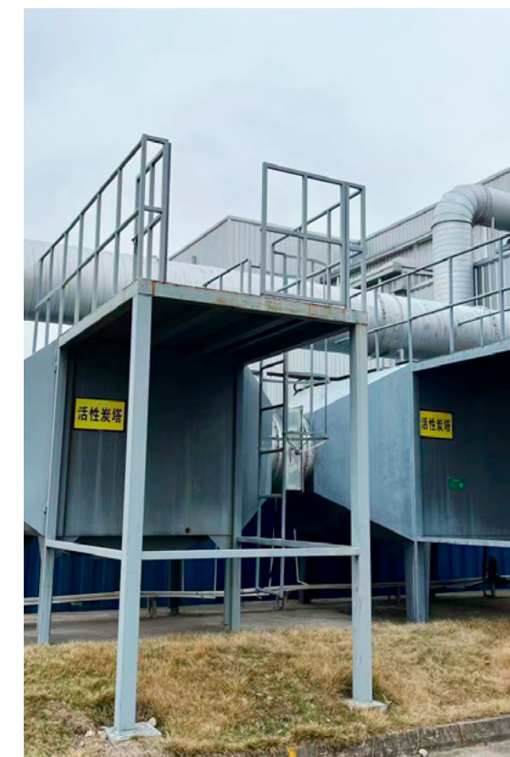
Installation à double charbon actif chez GC Suzhou
